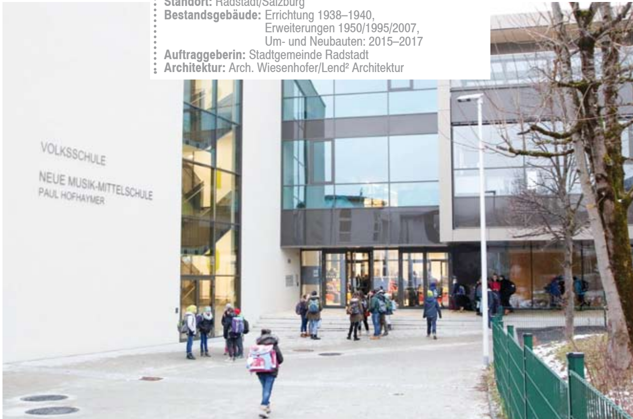
62 Außenansicht des Projektgebäudes; Foto: RAUM.WERT.cc
