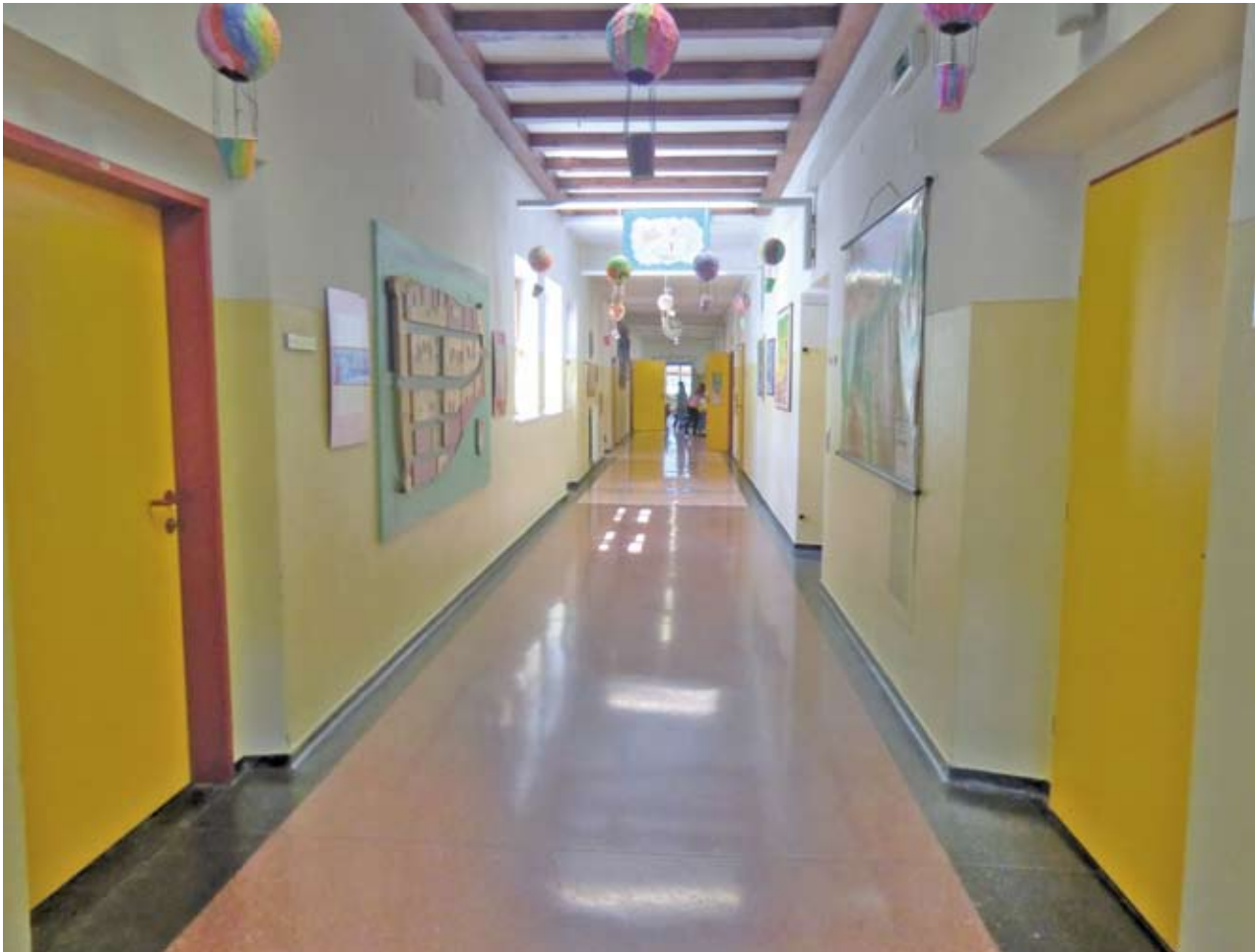
77 Gangflächen vor dem Umbau; Foto: RAUM.WERT.cc
