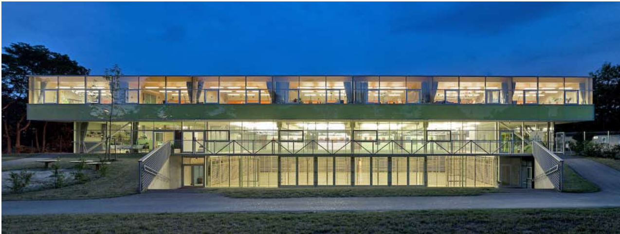
Abb. 49: Nordseite mit Turnhalle und Klassenzimmern
